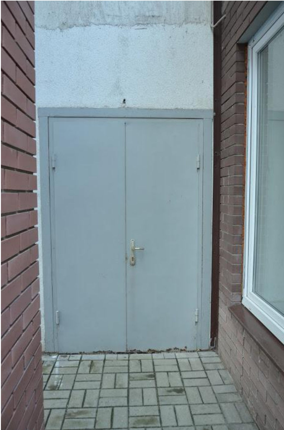
Рис. 10 Вхід до лекційного корпусу
